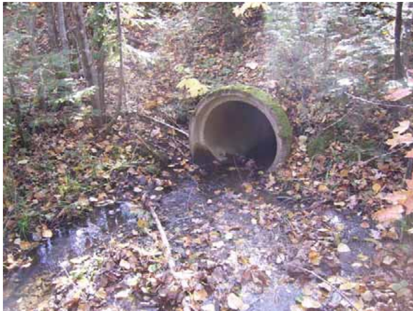
Photographie 12 : TC7, ponceau existant. Le débit y est très faible.
