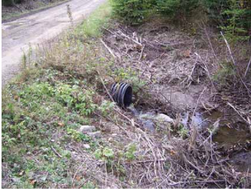
Photographie 5 : TC3, ponceau existant.
