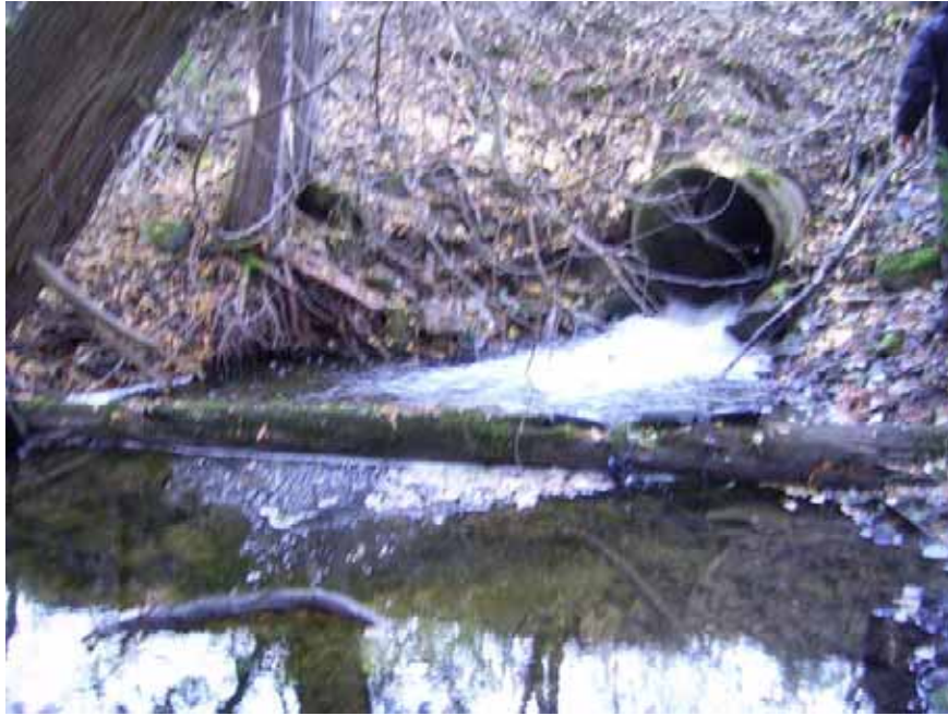
Photographie 9 : TC5, ponceau existant.
