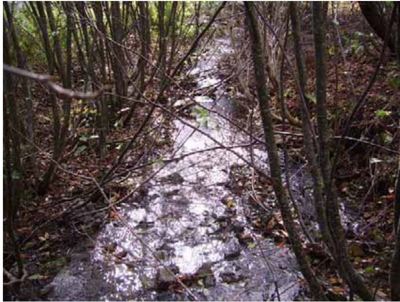
Photographie 7 : TC3, fossé de drainage.
